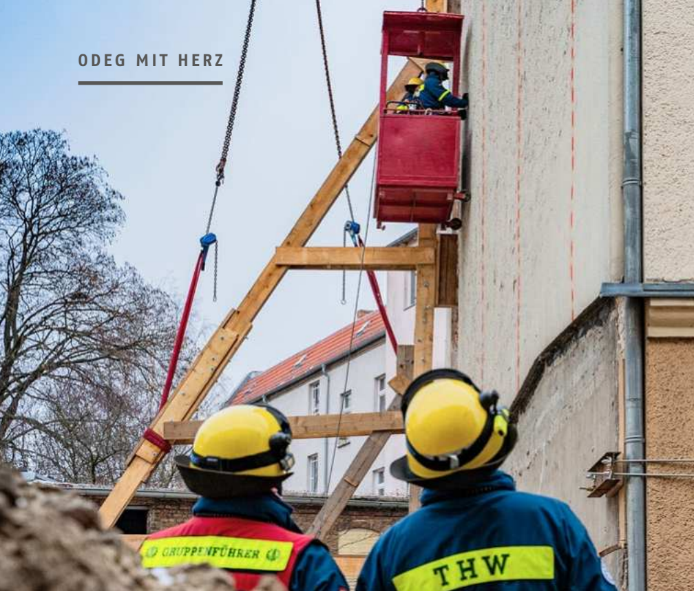
Einsatz Gebäudeabstützung in Köpenick
