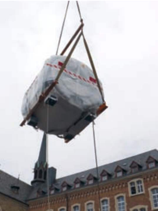
Nur mit dem Kran konnte der sechs Tonnen schwere Hightech-Koloss in den Innenhof transportiert werden.
